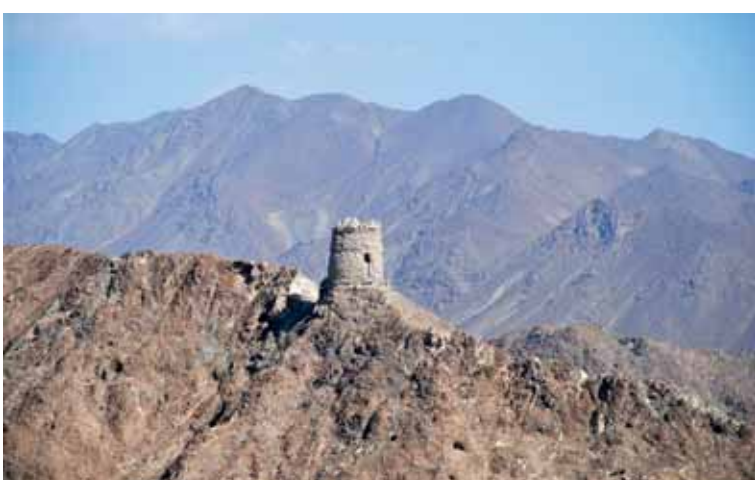
■ حصن القصبة الشهير يتوسط الحارة القديمة
