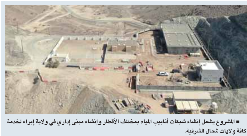
المشروع يشمل إنشاء شبكات أنابيب المياه بمختلف الأقطار وإنشاء مبنى إداري في ولاية إبراء لخدمة كافة ولايات شمال الشرقية.
