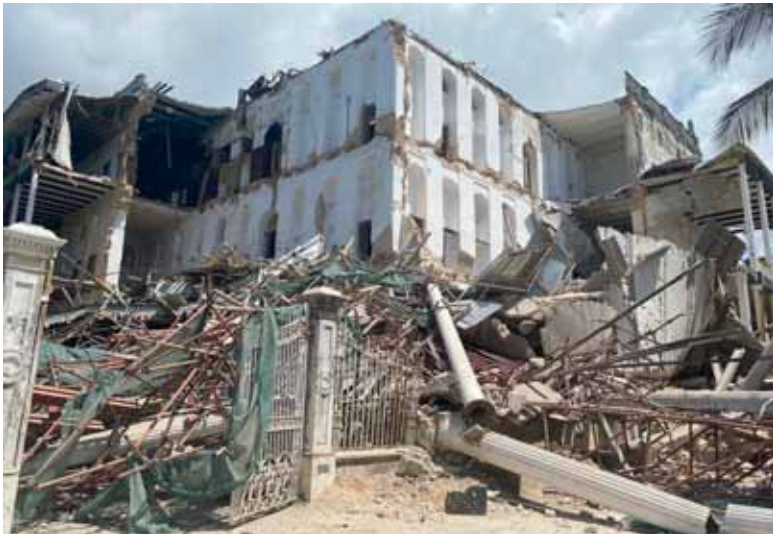
مشهد يوضح الانهيار الجزئي الذي لحق بالمبنى
