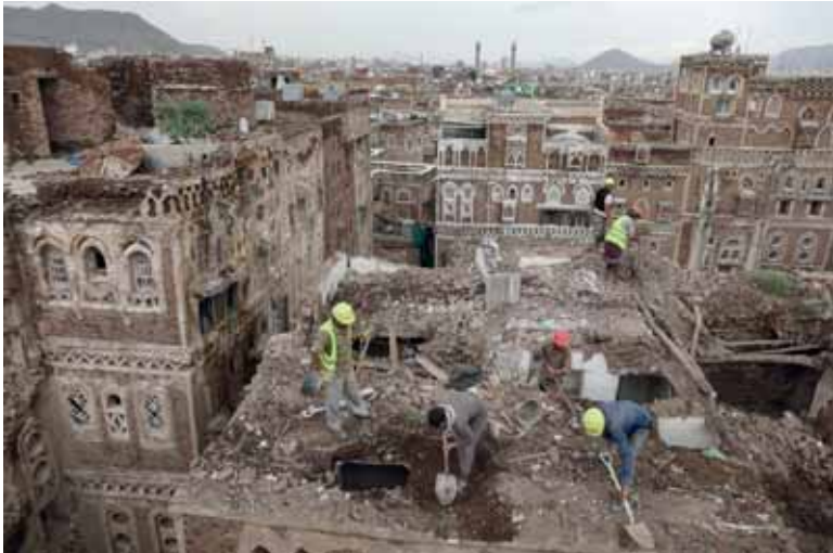
عمال يعيدون تأهيل مبنى دمرته الأمطار ضمن عشرات المنازل المسجلة لدى اليونسكو في صنعاء القديمة التي انهارت بفعل الأمطار الغزيرة بعد شهور من السيول والعواصف
