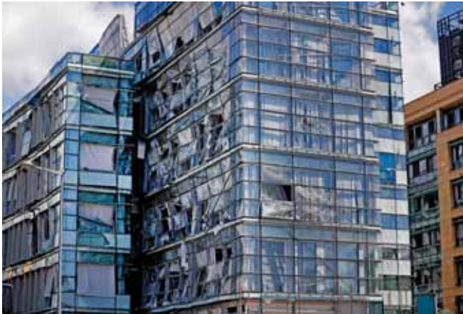
■ صورة توضح آثار الدمار الذي لحق بأحد المباني جراء انفجار مرفأ بيروت. الفب
