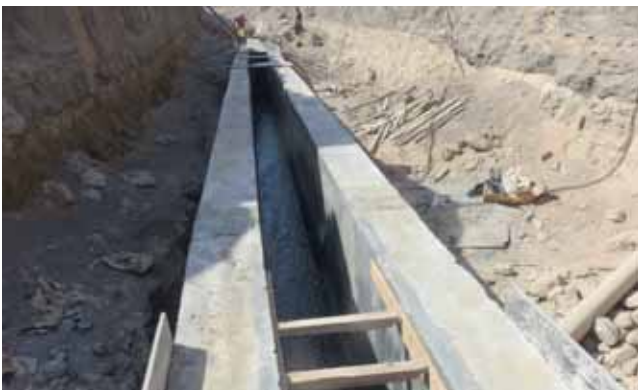
■ أعمال الصيانة تتمثل في إزالة الترسبات والعوالق من مجاري الأفلاج وفتح وشق القنوات المائية وصيانة الأماكن التي تتسرب منها المياه
