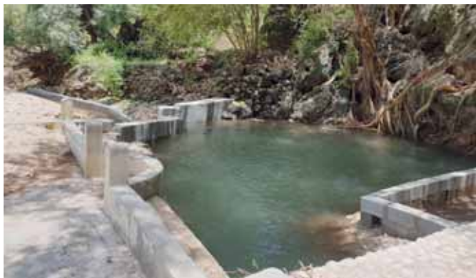
■ أعمال الصيانة تتمثل في إزالة الترسبات والعوالق من مجاري الأفلاج وفتح وشق القنوات المائية وصيانة الأماكن التي تتسرب منها المياه
