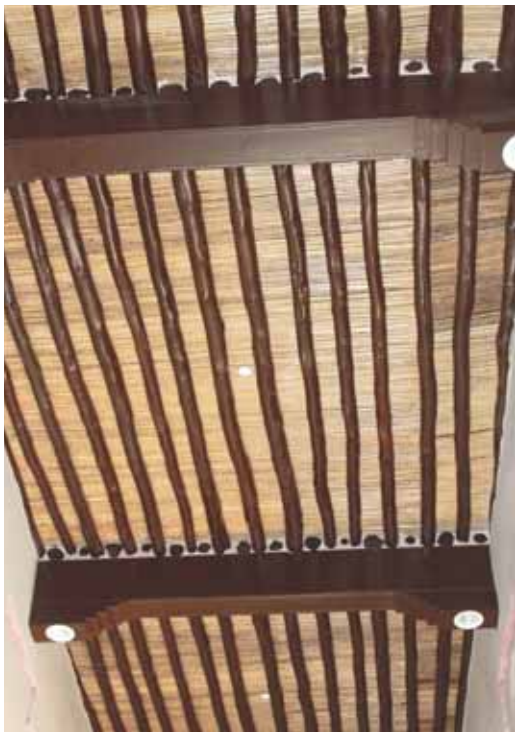
■ سقف المسجد بعد الترميم
