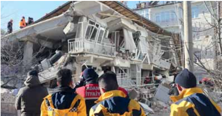
عمال الإنقاذ أمام إحدى المباني التي تصدعت جراء الزلزال
