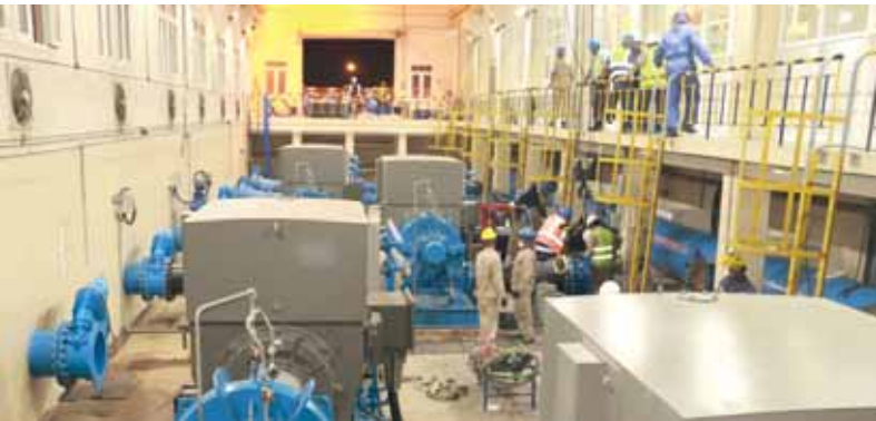
تعزيز عملية نقل المياه بأنابيب جديدة وربطها بالأنابيب الحالية
