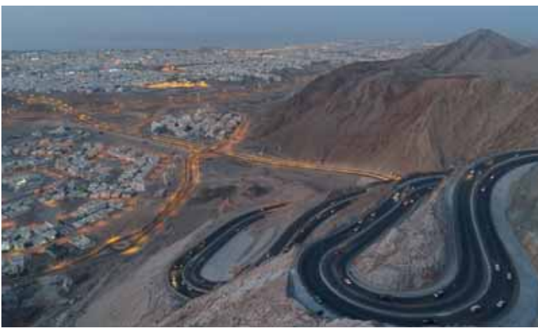
■ مشاريع إنشاء وصيانة الطرق بما يتوافق مع النمو العمراني
