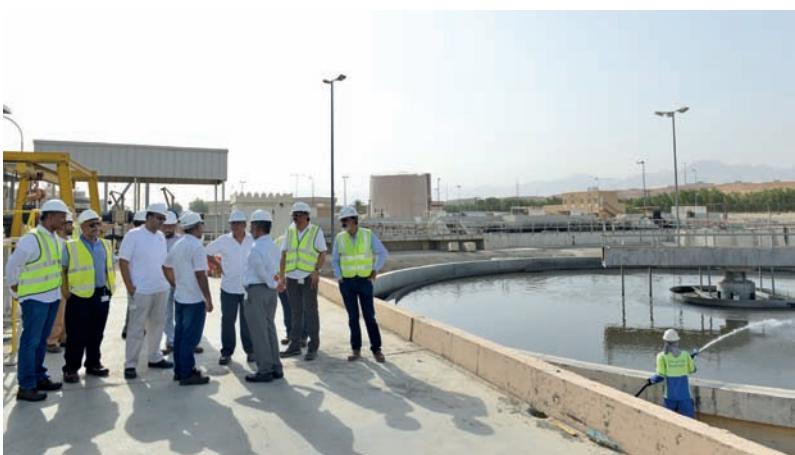
■ الرئيس التنفيذي لـ(حيا للمياه) أثناء زيارته للإدارة التنفيذية لمحطة معالجة مياه الصرف الصحي بالأنصب
