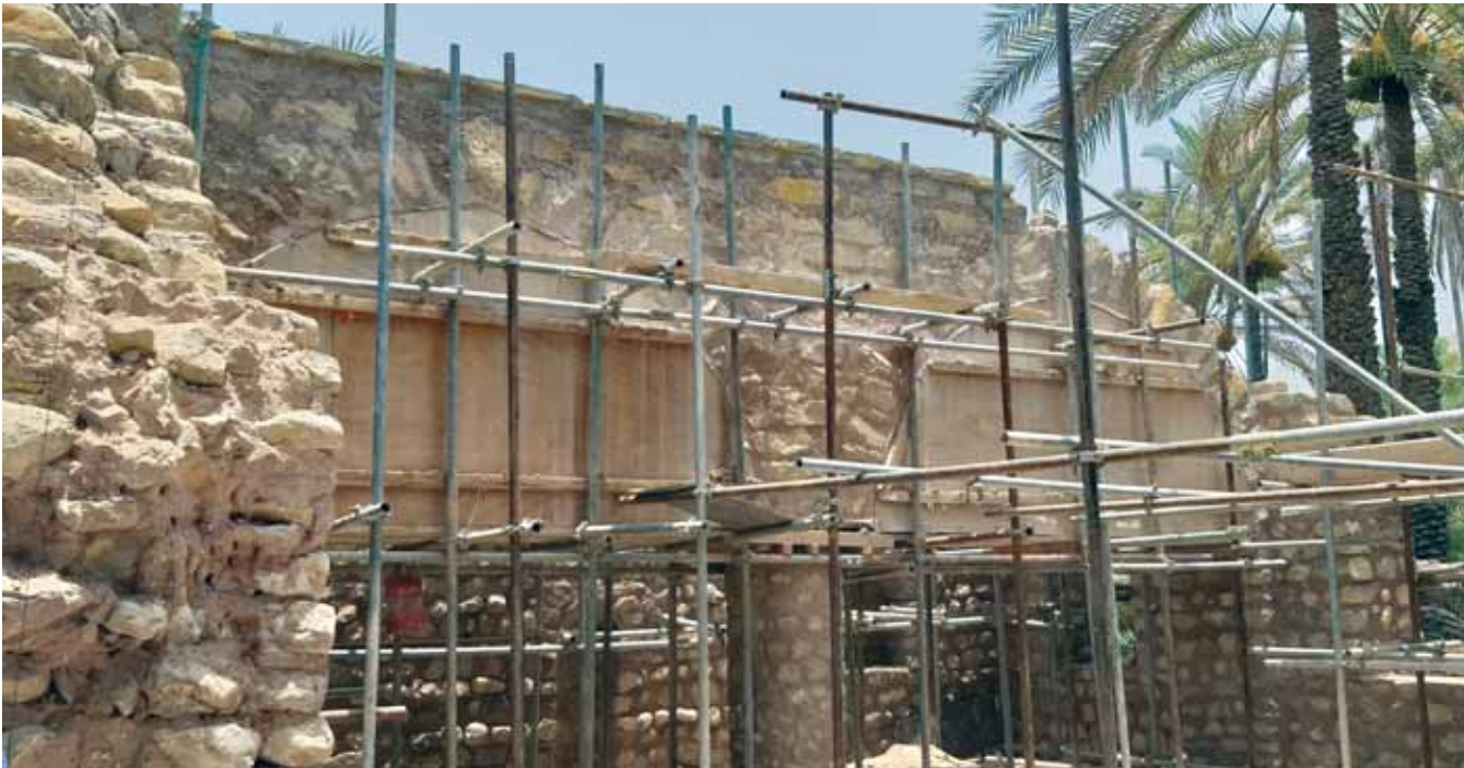
■ أعمال الترميم بمسجد العوينة الأثري
