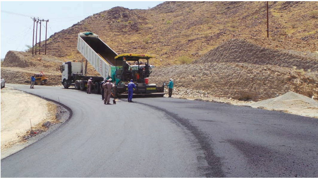
■ من أعمال رصف طريق (الحوقين ـ ملي) بولاية الرستاق
