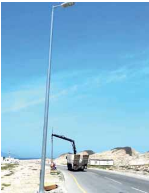
■ أثناء عملية تركيب الأعمدة بطرق جزر الحلائيات
