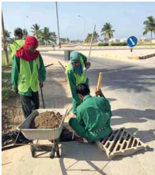
■ من أعمال صيانة غرف تصريف المياه في الشوارع في صلالة
