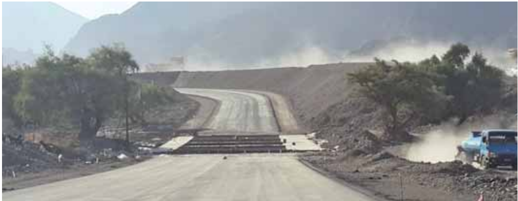
أثناء أعمال رصف الطريق
