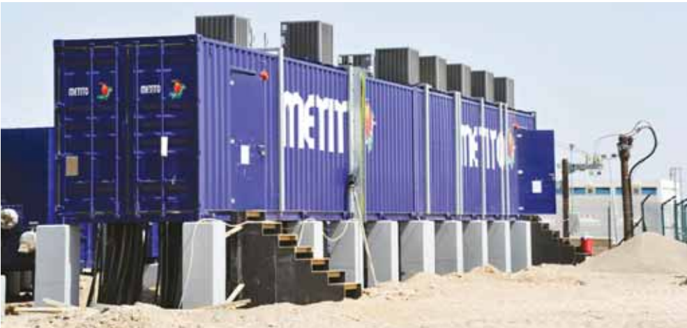
■ أحد إنشاءات محطة تنقية المياه بحوض المسرات
