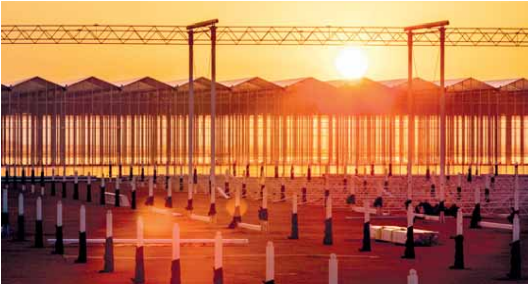
■ تتسارع وتيرة العمل في مشروع مرآة لتوليد البخار بالطاقة الشمسية الذي تنفذه شركة تنمية نفط عمان وجلاس بوينت سولار بحقل أمل النفطي
