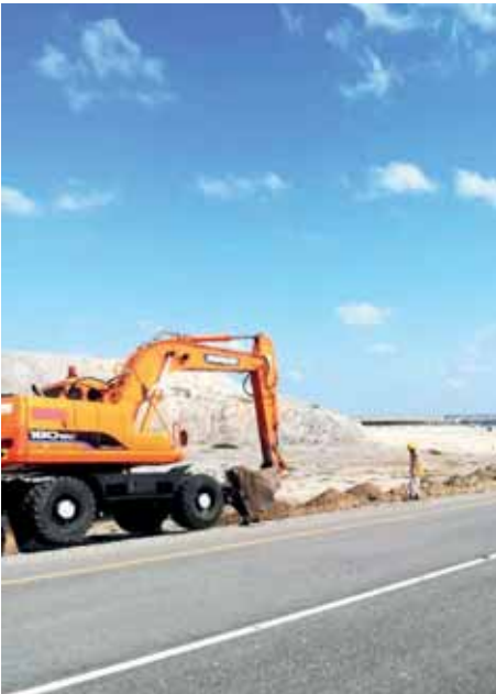
■ تنفيذ أعمال الإنارة للطرق بجزر الحلاينيات
