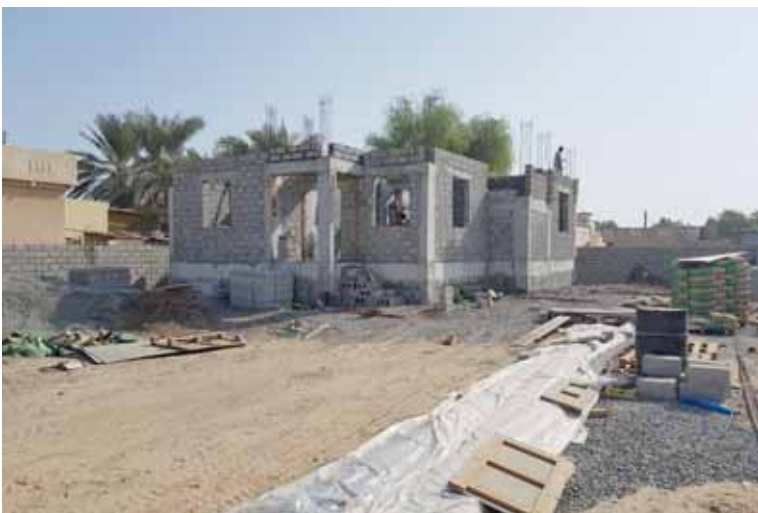
■ أحد المنازل الحالية التي يتم بناؤها
