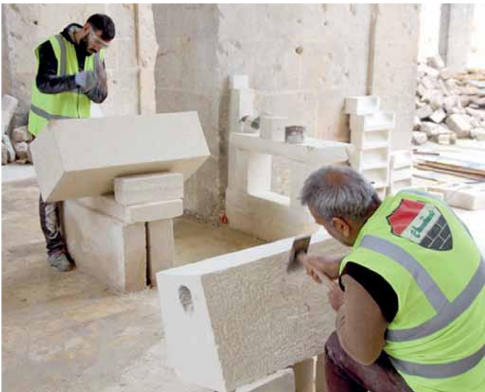
■ صورة بثقتها وكالة الأنباء السورية الرسمية " سانا" لعاملين يباشرون عمليات ترميم الجامع الأموي الكبير في مدينة حلب، حيث أوضحت الجهات المعنية بأن عمليات ترميم الجامع تسير بخطى متأنية ودقيقة لتشمل كل حجر فيه طالته يد الإرهاب التي حاولت طمس معالم هذا الصرح الحضاري الأثري الذي صمد بوجه أعنى الزلزال عبر المراحل التي مر بها منذ بنائه.
