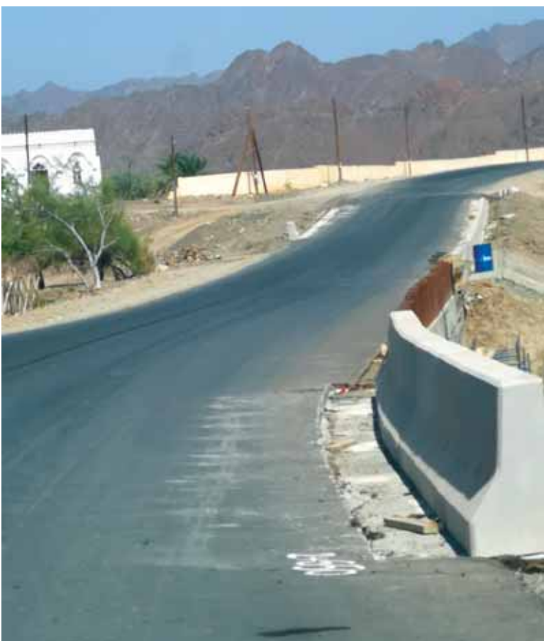
■ عمل عبارات صندوقية فوق الطريق لتجنب طريق الأودية
