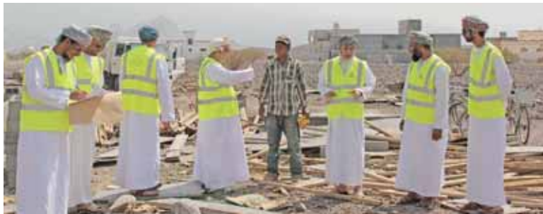
■ المختصون في بلدية الحمراء خلال زيارتهم إحدى المنشآت تحت الإنشاء
