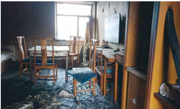
■ أثار الحريق في إحدى غرف فندق في هاربين الذي تعرض للحريق، مقاطعة هيلونغجيانغ في شمال شرق الصين
