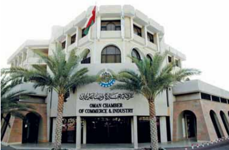
■ المبنى الرئيسي لغرفة تجارة وصناعة عمان
