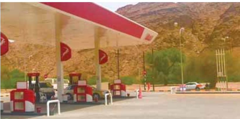
■ محطة تعبئة الوقود الجديدة بمنطقة يتي
