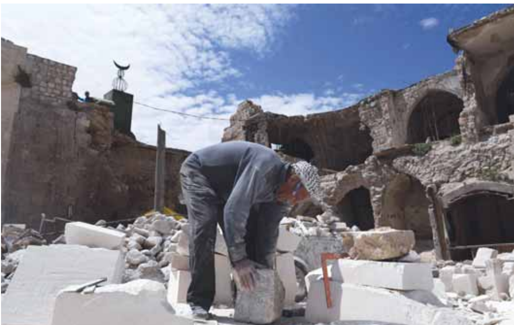
■ عامل بناء يقوم بوضع الحجارة تمهيد لعملية بناء ضمن منظومة إعادة إعمار مدينة حلب
