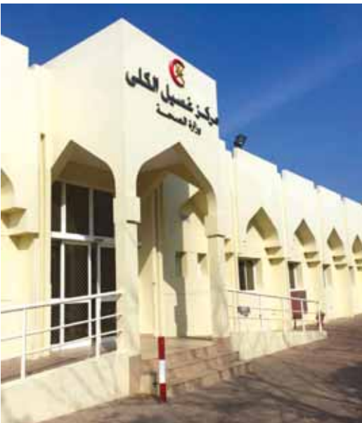
■ مبنى وحدة غسيل الكلى ببوشر ■ من المصدر.
