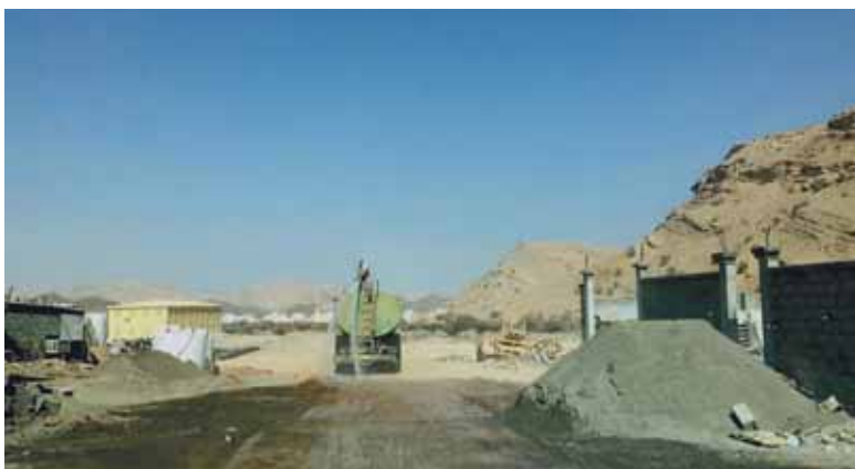
■ من أعمال رصف الطرق الداخلية
