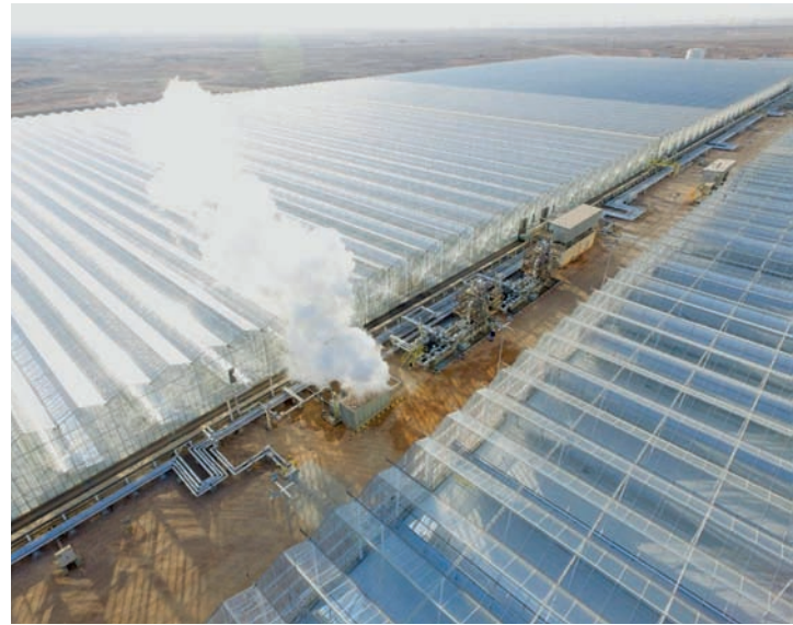
محطة «مرآة» صممت خصيصاً لتسخير أشعة الشمس في إنتاج البخار اللازم لعمليات الاستخلاص المعزز للنفط بالأسلوب الحراري
