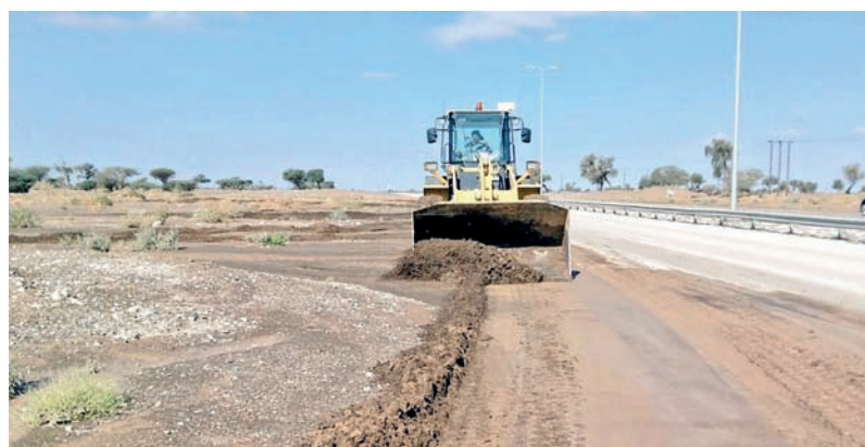
■ من أعمال صيانة الطرق
