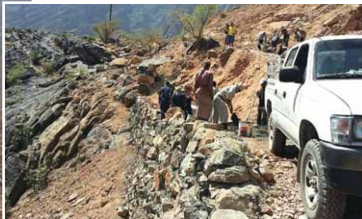
■ أثناء سفلقة أحد أجزاء الطريق بالأسمنت
