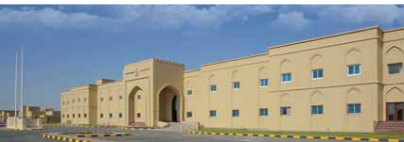
■ مبنى مركز شرطة نخل
