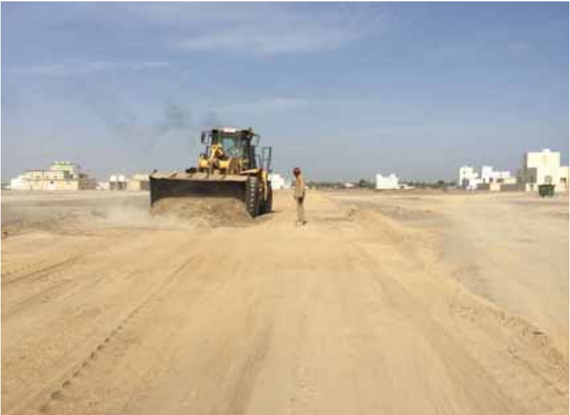
■ القيام بأعمال تمهيد الأرض لرصف أحد الطرق
