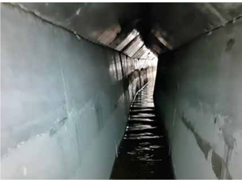
■ شكل الفلج من الداخل بمنطقة الخشف بعد الانتهاء من صب الخرسانة
