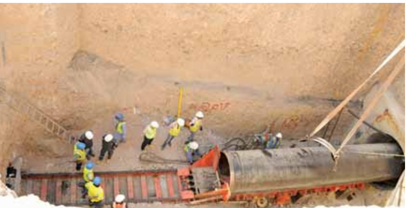
■ تنفيذ أعمال حفر بتقنية النفق اللولبي (الحفر بالأنفاق) للمشروع
