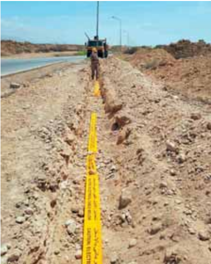
■ أعمال توصيل الإنارة للطرق الرئيسية والداخلية والمرافق
