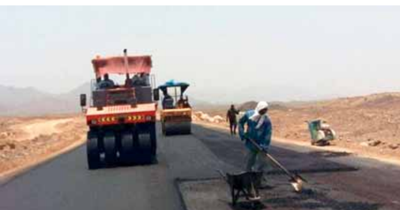
■ أعمال رصف الطرق بالمناطق الجبلية بالخابورة من المصدر
