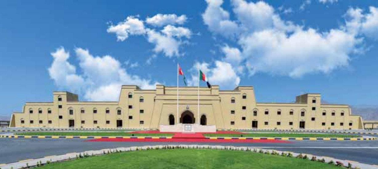
■ مبنى قيادة شرطة محافظة البريمي
