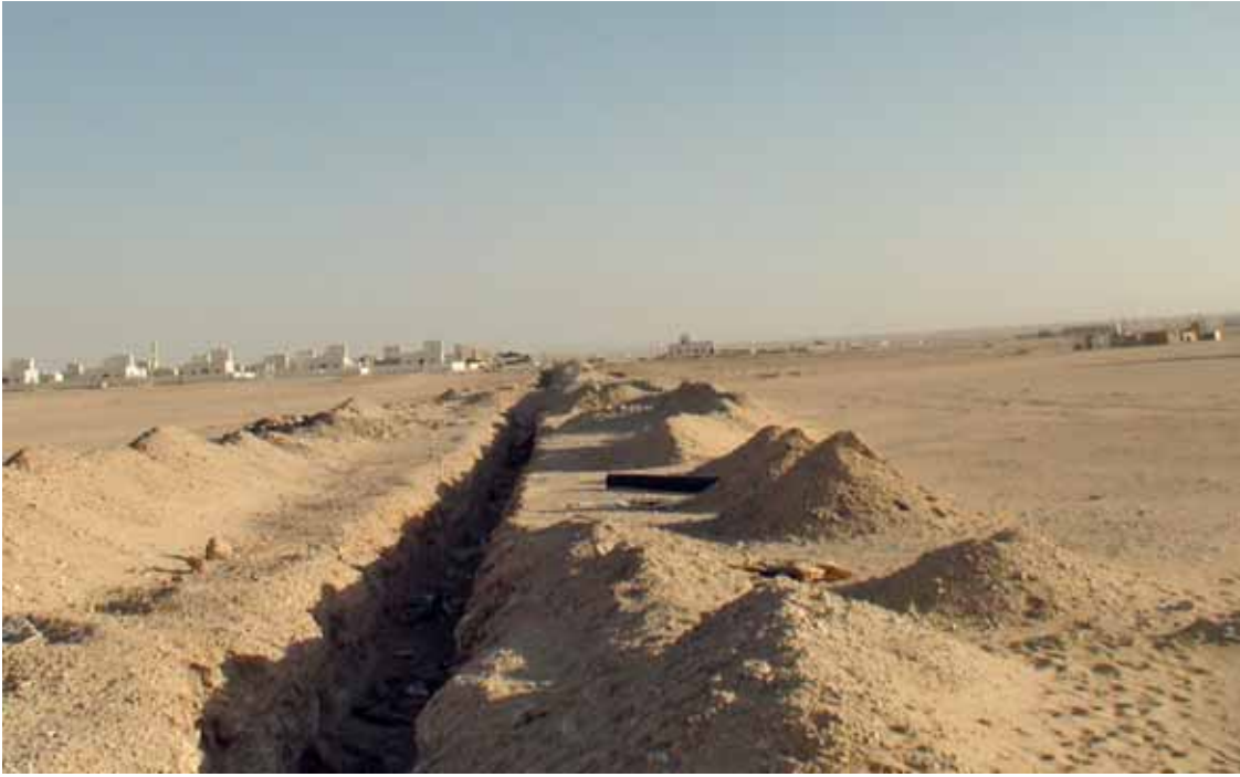
■ مشروع الصرف الصحي أحد المشاريع التي يتواصل العمل بها
