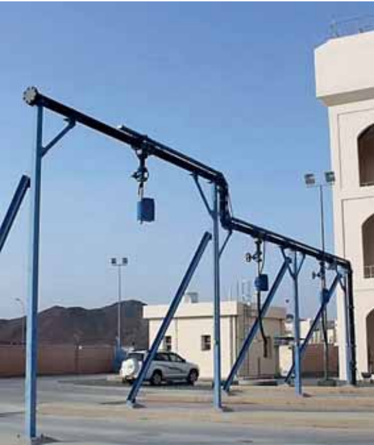
■ محطة مياه لا مياه بها
