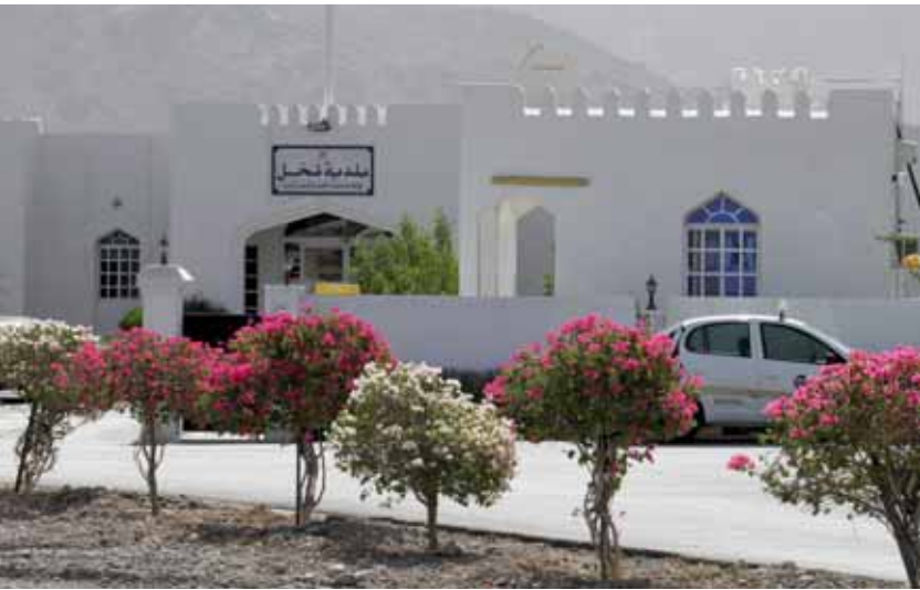
■ منظر عام لمبنى البلدية بالولاية
