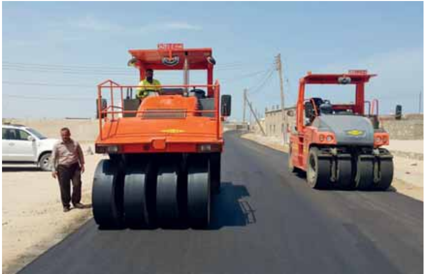
■ من أعمال رصف طريق منطقة الخبة بولاية جعلان بني بو علي
