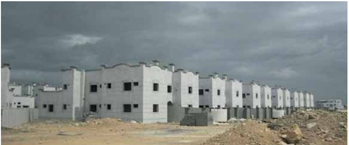
■ وحدات سكنية مزدوجة قيد الإنشاء
