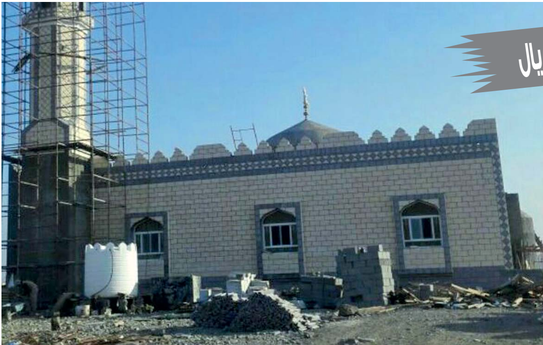
■ من مراحل الأعمال الإنشائية لبناء المسجد
