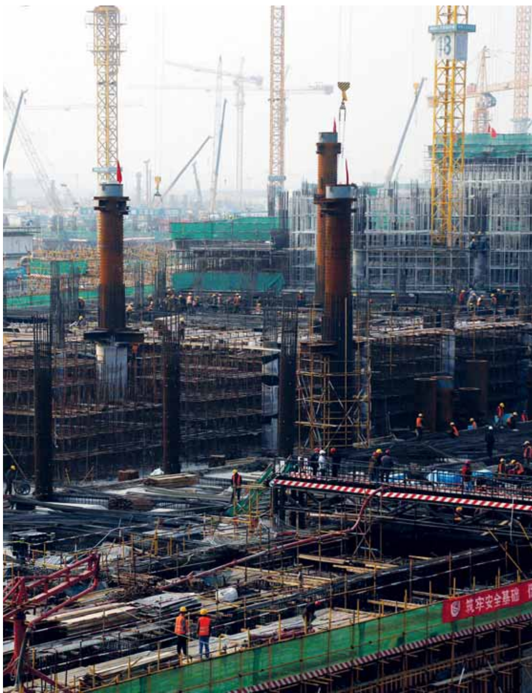
■ أعمال الإنشاء جارية في بناء مطار بكين الجديد جنوب بكين امس
