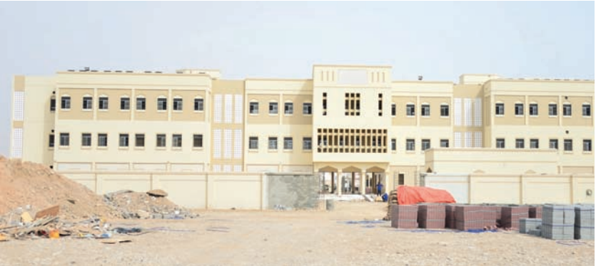
■ أحد المباني المدرسية الجديدة بجنوب الشرقية
