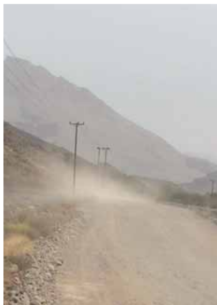
■ تطاير الغبار بسبب عدم رصف الطريق
