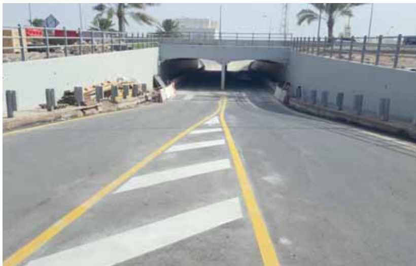
■ النفق الذي يربط منطقتي الغشبية والمعبيلة الشمالية بالمعبيلة الجنوبية.
