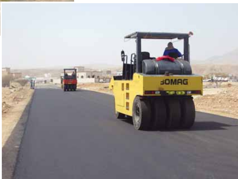
■ من مشاريع رصف الطرق الداخلية
