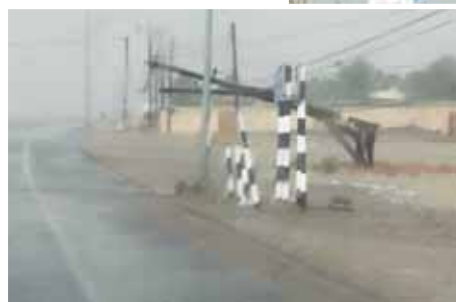
■ سقوط أعمدة كهرباء في بعض قرى عبري
