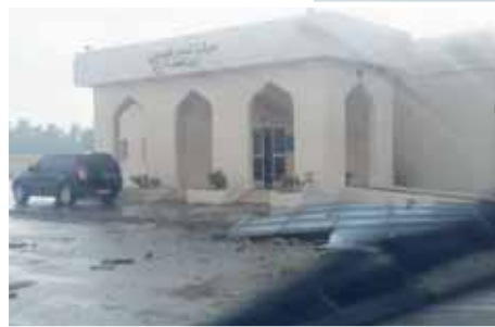
■ تعرض بعض مرافق مركز تنعم الصحي لأضرار
